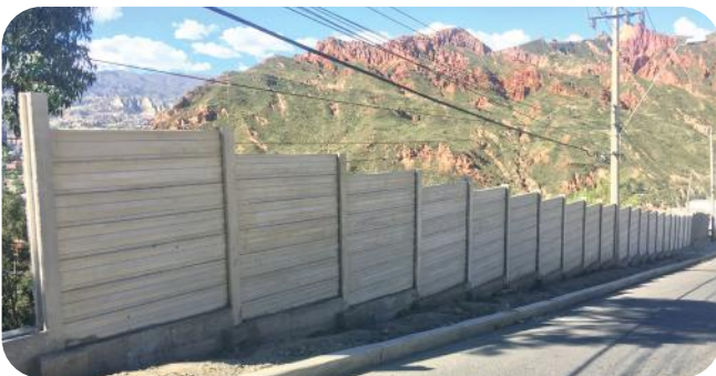
POSTES PM/PLACAS LAM para muros de cerco.
