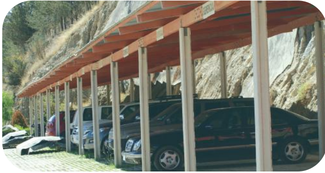
POSTES PMR para áreas de parqueos.
