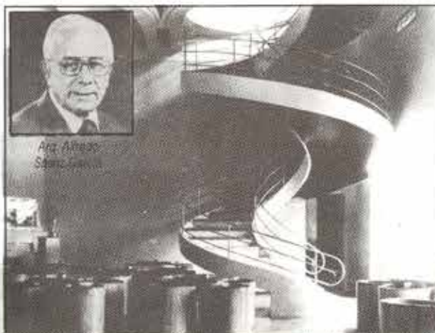
Vista parcial del gran Hall y la novedosa escalera helicoidal
